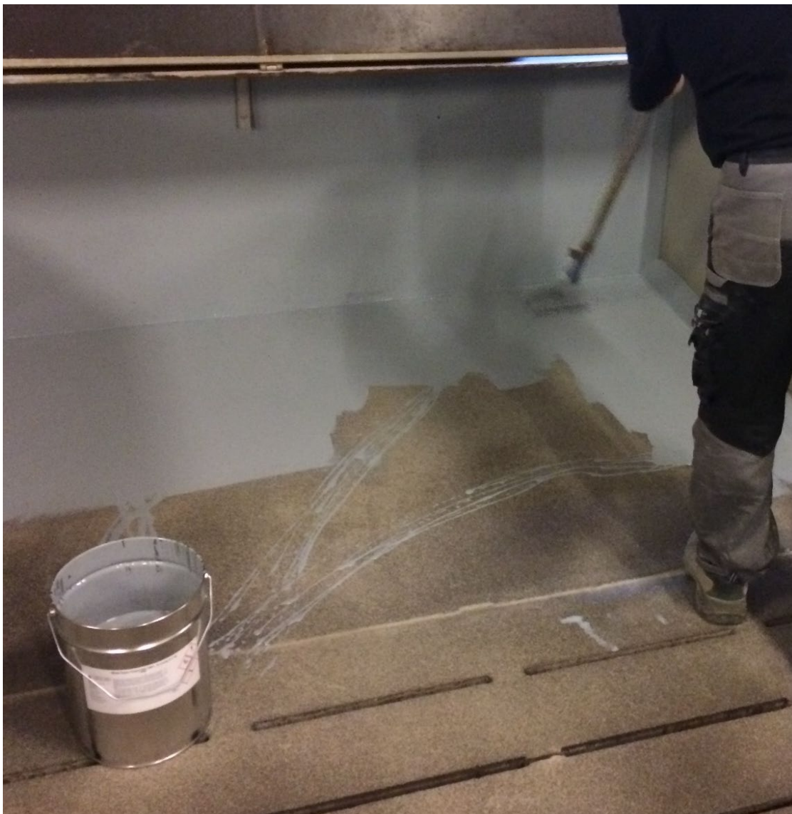
Figur 3. Der blev etableret trelaget-epoxyoverflader på gulve og hulevæg. Det midterste epoxylag på gulvet blev tilført strukturmateriale for at gøre gulvet skridsikkert.
